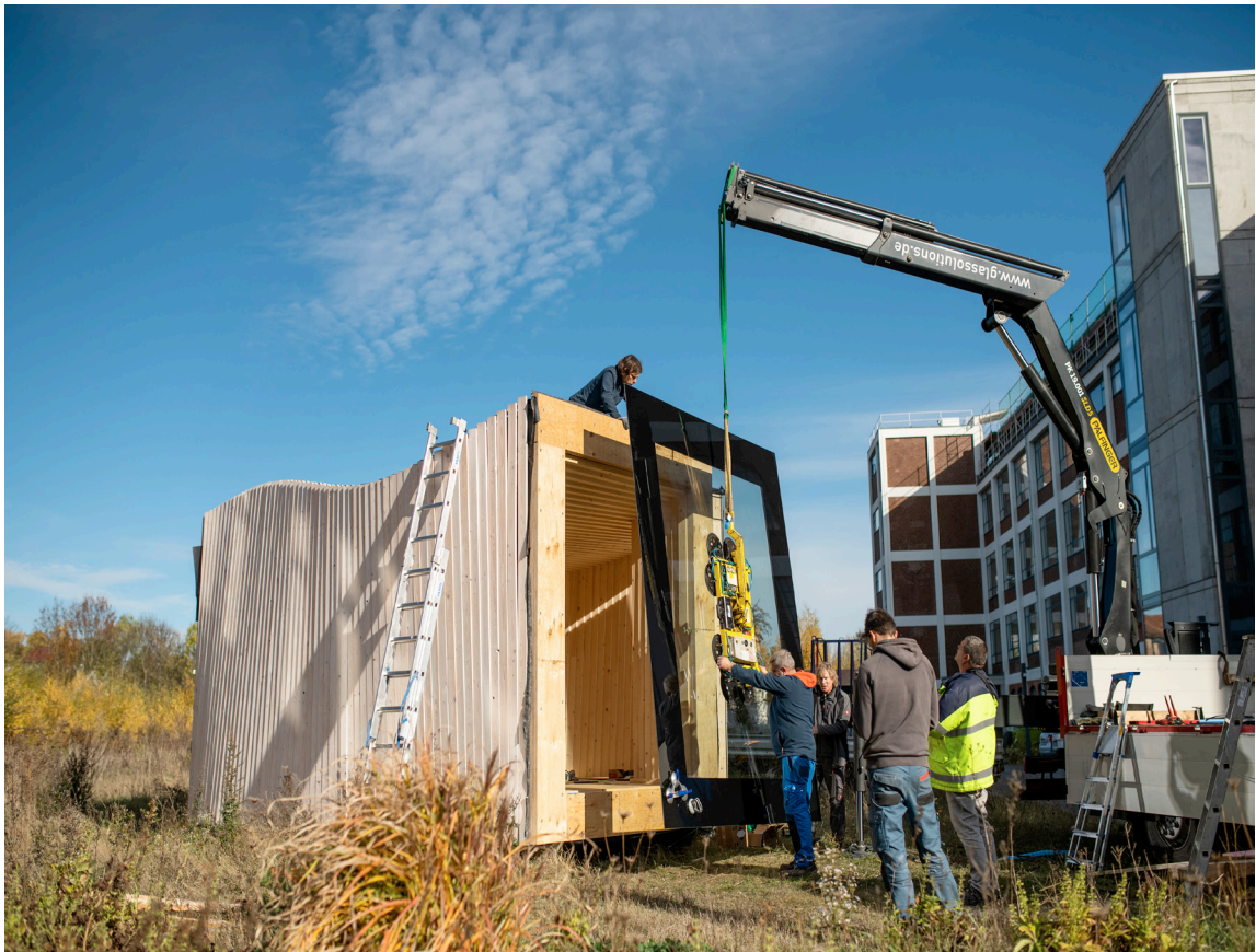
Timber Prototype House, Einbau Glasfronten / © IBA Thüringen, Foto: Thomas Müller
