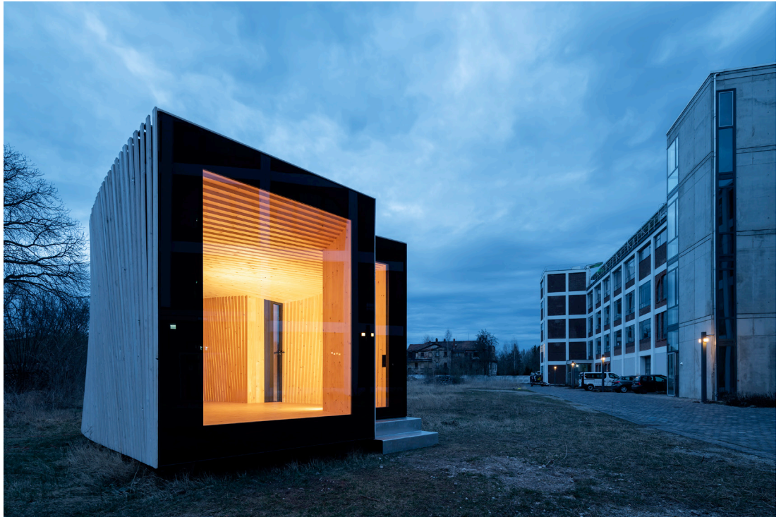
Timber Prototype House, Eingangsseite, Abendstimmung mit Eiermannbau / © IBA Thüringen, Foto: Thomas Müller
