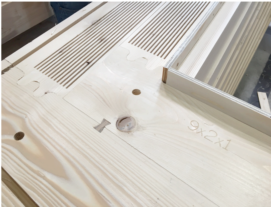
Timber Prototype House, Verbindung Rahmenecke / © ICD Stuttgart, Foto: Oliver Bucklin
