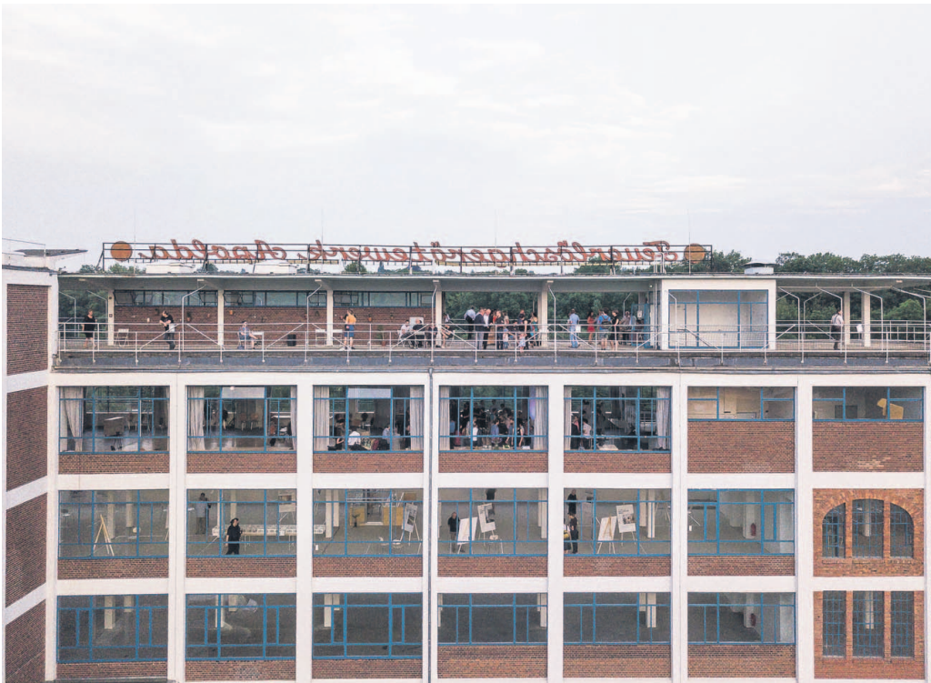
Der Eiermannbau in Apolda gilt als Ikone der Industriekultur
